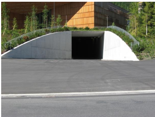
Einfahrt Tunnel zum Lieferanteneingang
